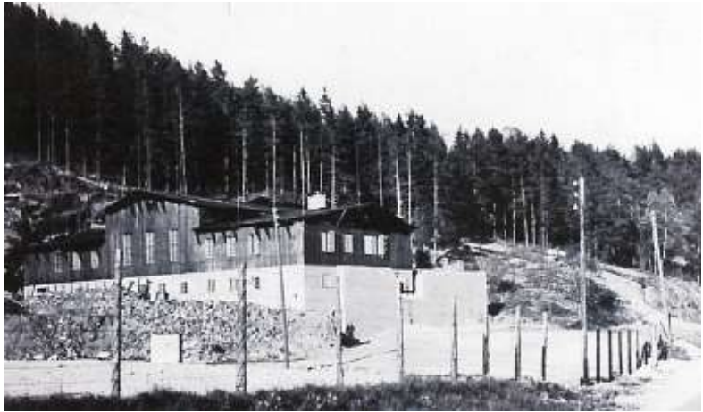
Fig.31: Fjellhallen, Katedralen, brant rett etter krigen. Det skal ha vært planlagt kontorlokaler her. Navnet bunner visstnok i at tyskerne kaller fjellhaller for katedraler.
