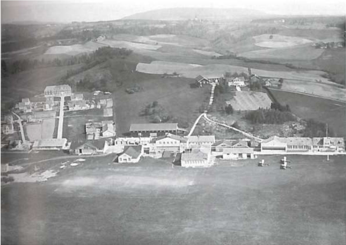
Fig 7: Et velegnet oversiktsbilde for å vise Kjellers gradvis utvikling (Slottemo 2012:119): «Kjeller (Skoleplassen) i slutten av 1920-årene. Fra venstre ser vi boligfeltet og kasernen, flyfabrikken i midten og flyskolens bygninger til høyre. Kasernen ble utvidet mot vest i 1926, men har ennå ikke fått utvidelsen mot øst som kom i 1930. Kjeller gård øverst i bildet» .
