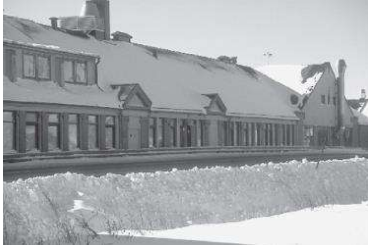
Fig. 19: Foto av Aministrasjonsbygningen Forsvarsbyggs registrering med fasafen ut mot Fetveien
